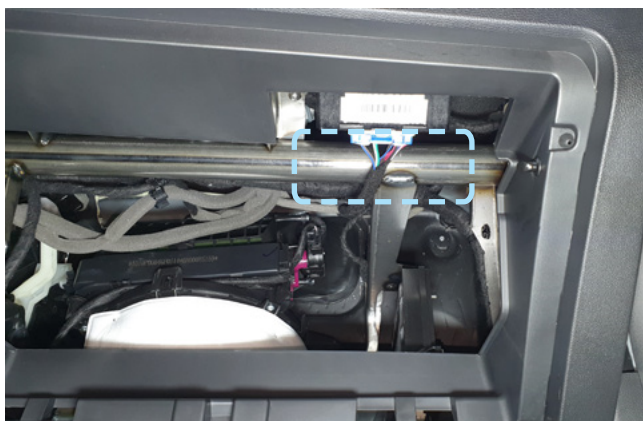
Фото 2.7. Пример расположения центрального блока охранно-телематического комплекса
